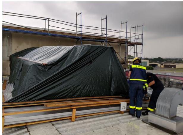
Die Helfer der Bergungsgruppe bauten anschließend im Dauerregen eine Regenablaufrinne und setzten weitere Folien zur Abdichtung des Daches ein.
