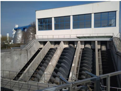
Neben den zahlreichen Fragen, auf die Herr Minich immer eine Antwort wusste, konnten die Helfer einen guten Einblick in die Funktion einer Kläranlage gewinnen. An diesem sonnigen Tag kamen pro Sekunde 800 Liter Abwasser an, dies entspricht ca 10 Badewannen. Die ganze Anlage mit mechanischer Vorreinigung, Sand- und Fettabscheidern so-wie dem „Herzstück“ der Biologischen Reinigung funktioniert wie eine Fabrik, die sauberes Wasser produziert. Zur
