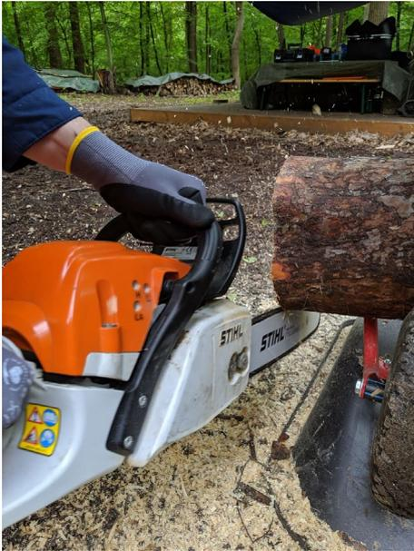
Da der Waldboden sehr weich ist, wurde die Stellfläche entsprechend mit Holzplatten ausgelegt, um eine Lastverteilung zu erreichen. Nun konnten die Maße für den neuen Unterbau ermittelt und mit der Kettensäge dann entsprechend das Holz zugesägt werden.
